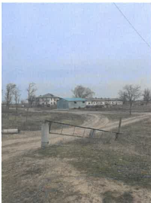
Accesul spre Conacul Sihleanu. Cercetare de teren Total Business Land 2022
