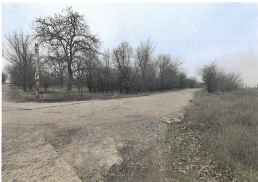
Starea drumului de acces spre Conacul Orezeanu din Gara Traian. Cercetare de teren – Total Business Land 2022
